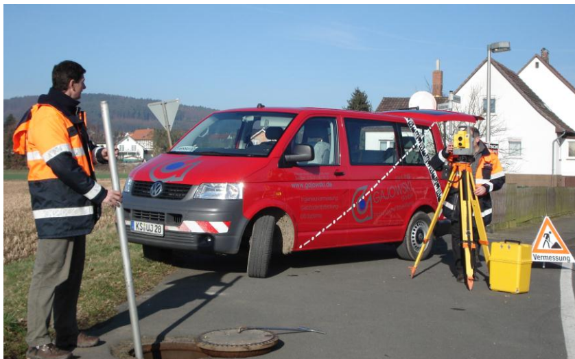
Schachtvermessung mit Tachymeter und Kanalstab
