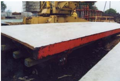
Schalungselement (Holz) mit Dränvlies
