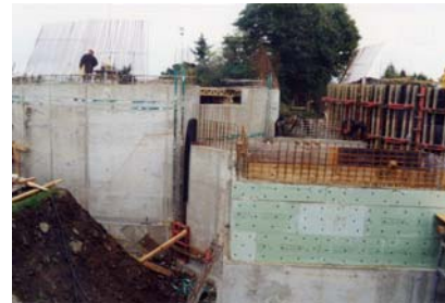
Wände der Wasser- und Schieberkammer
