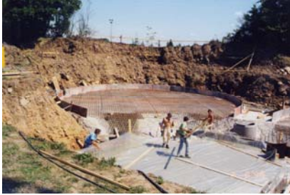
Sohle der Schieber- und Wasserkammer
