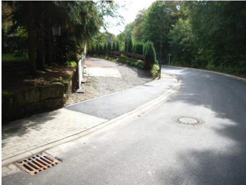
Hüttenbergstraße nach dem Ausbau
