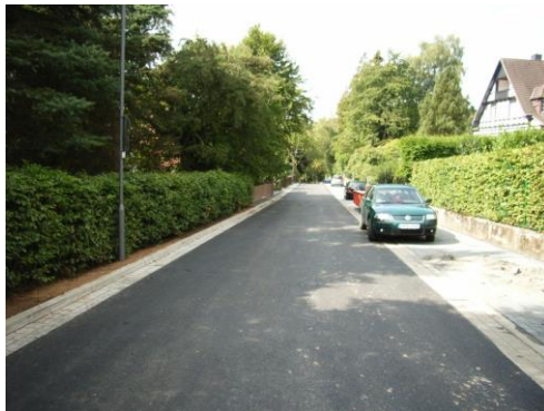
Krähahnstraße nach dem Ausbau
