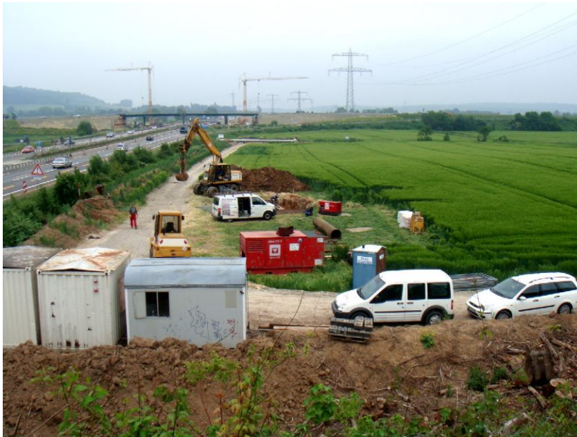
Baustelle Startgrube DN 1200
