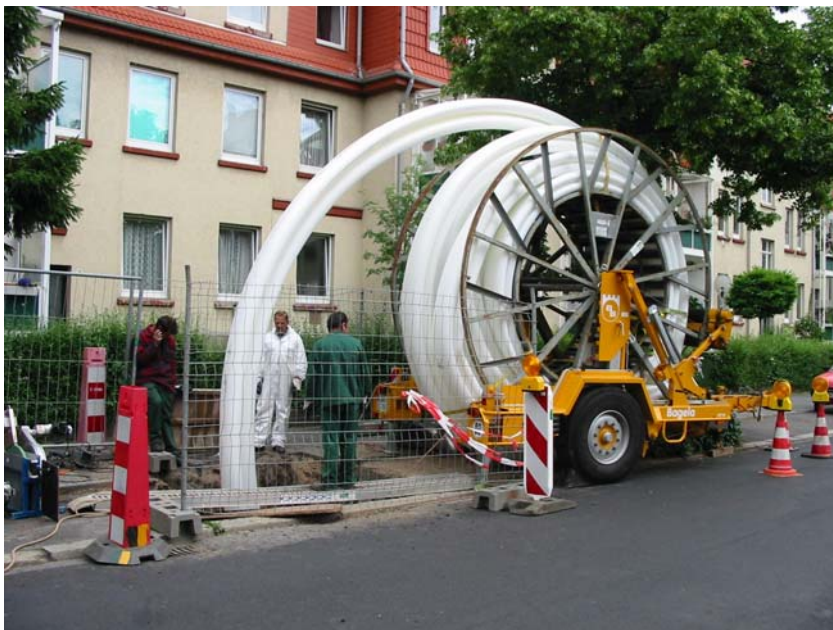
Kanalsanierung durch Liner, Einbau von der Rolle in eine vorhandene Haltung
