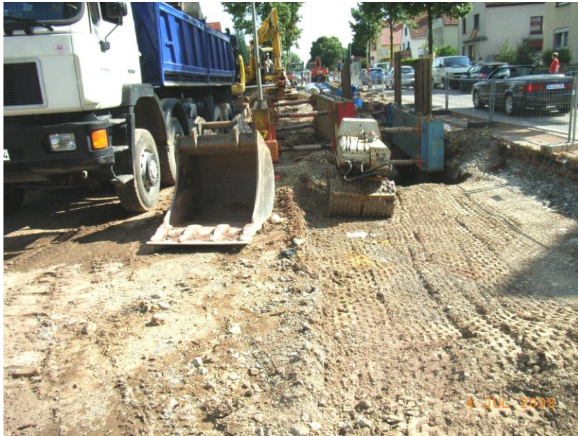
Bau unter halbseitiger Fahrbahnspernung in der Reinhäuser Landstraße
