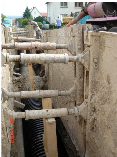
Einbau Flüssigboden
