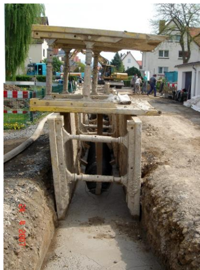
Rohrgraben mit Flüssigboden verfüllt
