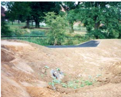
Dammscharte im Bau
