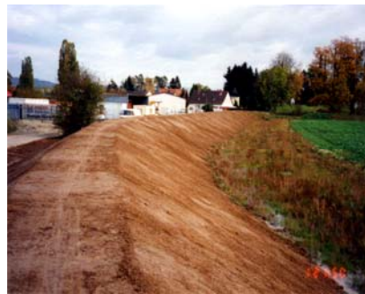
Nördlicher Teil des Damms
