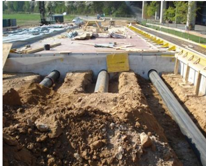
Einzug Entwässerung unter Brücke
