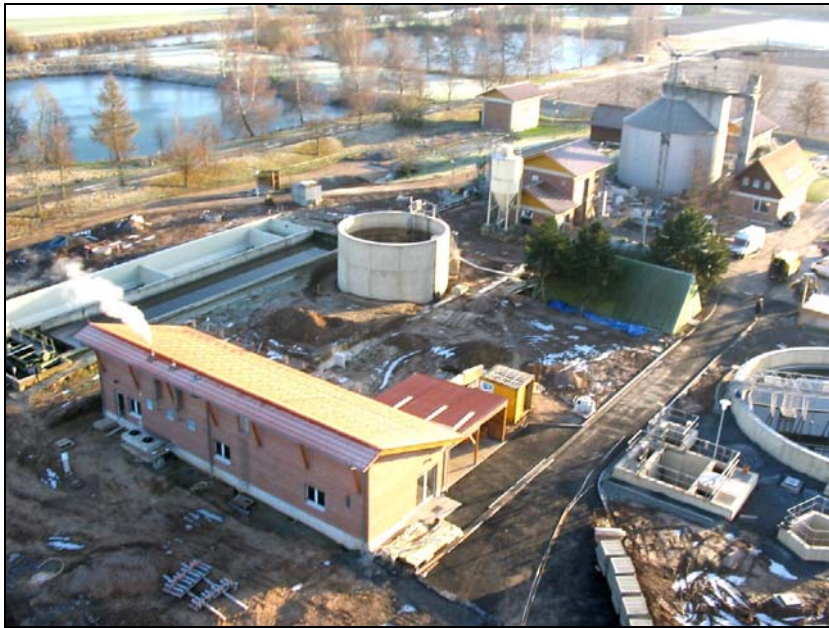
Neubau der Gebläsestation
