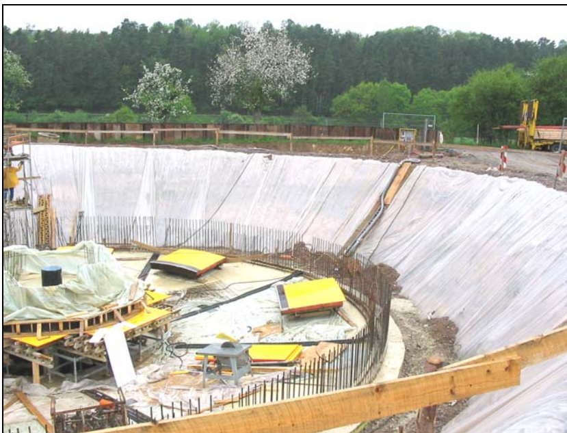
Bau der Nachklärbecken
